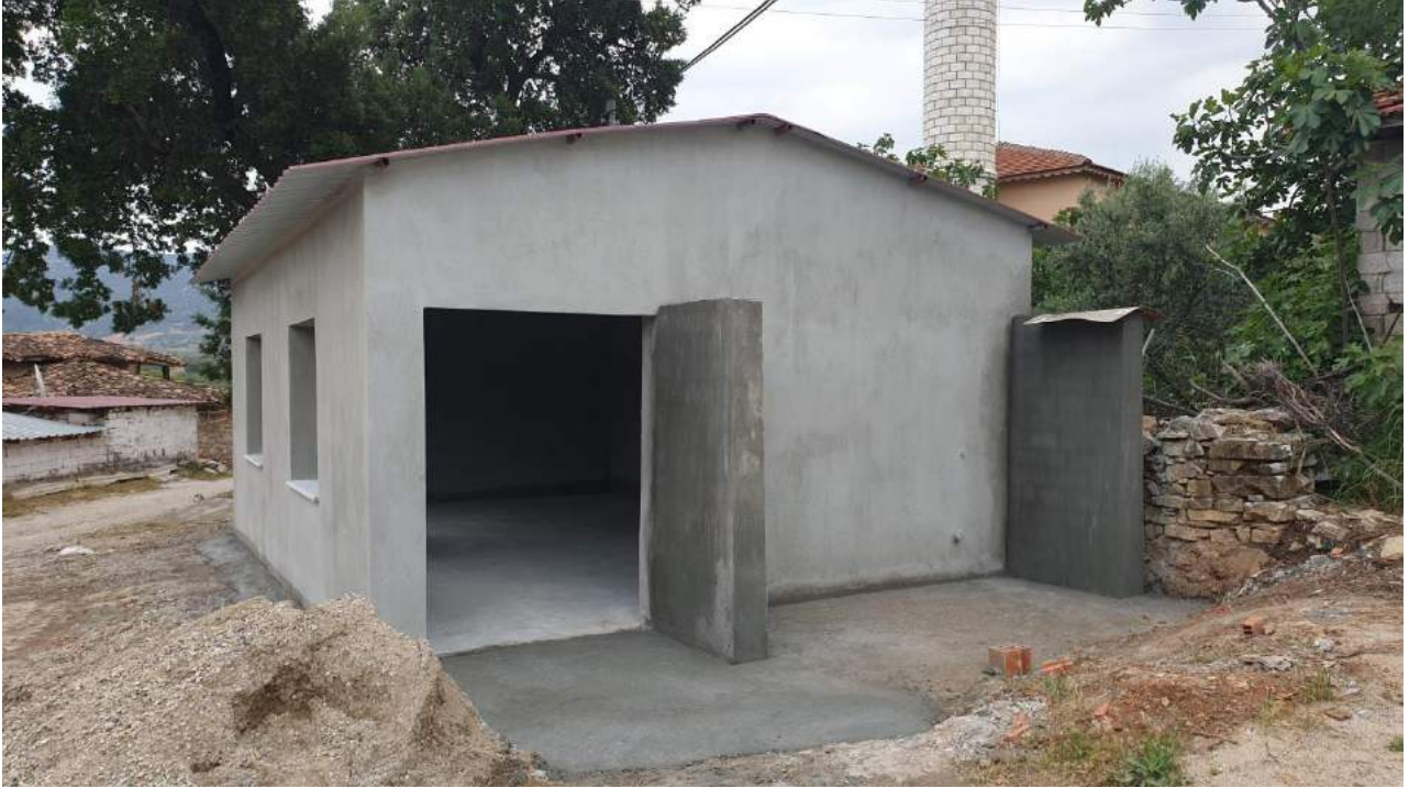
ÇALTILIÇUKUR AŞEVİ İNŞAATI
